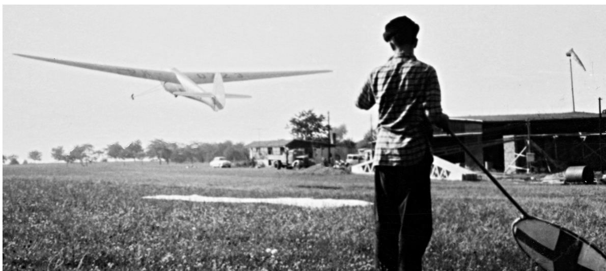
Na navijáku startuje „Šohaj 2“ OK-0723, železobetonové nosníky jsou vyskladněny před hangárem a „altánek - byt náčelníka“ má novou fasádu; Nový Dvůr, srpen 1961
