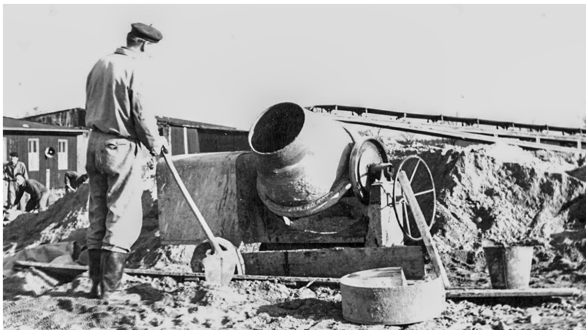
Při betonování základů hangáru byla jediným pomocníkem míchačka; Nový Dvůr, duben 1961
