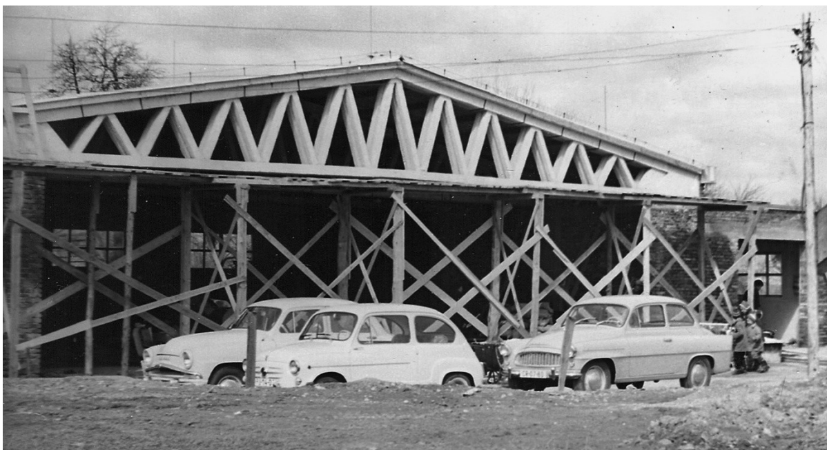
Hangár konečně pod střechou; Nový Dvůr, prosinec 1961
